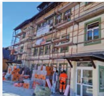
Generalsanierung vom Mehrzweck- haus in Oberweißburg
