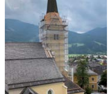
Unterstützung unserer Pfarre: Kirchen- und Kapellenrenovierungen
