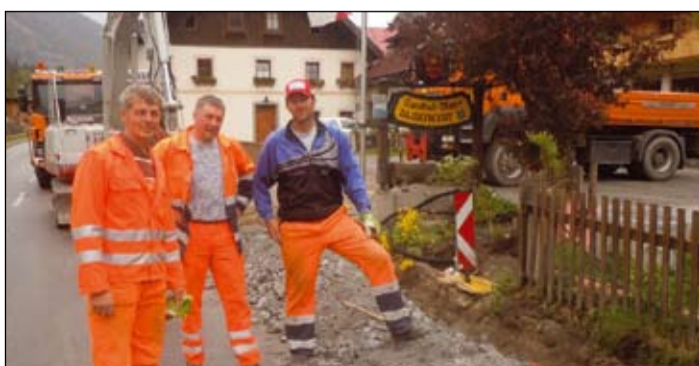
Sanierungsarbeiten in Fell
